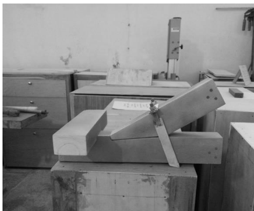
Gambar 4. Hubungan Kaki Kuda-kuda dengan Balok Tarik cara 3 (Dokumentasi)
