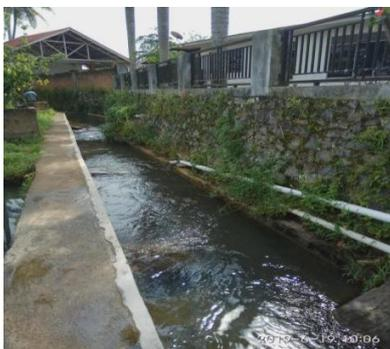
Gambar 3. (a) Pengambilan liar disaluran dan (b) pembuangan langsung masuk ke saluran
