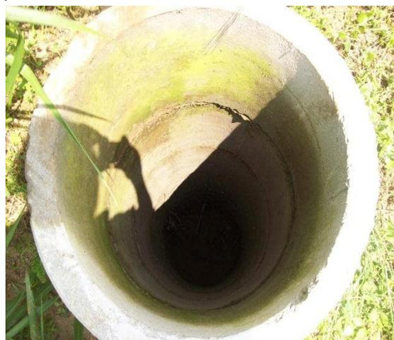
Sumur gali dari dengan buis beton sedalam 3 meter dipasang pada 21 Agustus 2009 untuk memantau gerakan tanah longsor arah miring di sebelah timur Punden.
