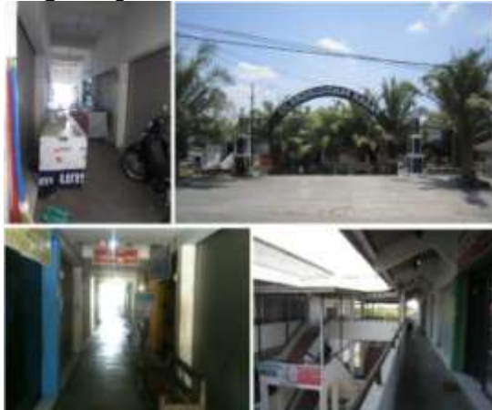
Gambar 1 Kondisi Eksisting Pasar Panggungrejo Sumber: Dokumentasi Yohanita, 2015
