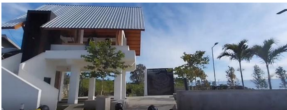
Gambar 9. Bangunan baru seperti ruang perkumpulan ( Bantaya ) diadaptasi arsitektur lokal Bantaya di Balaroa, Karya Arsitek oleh Rachmat Saleh.
