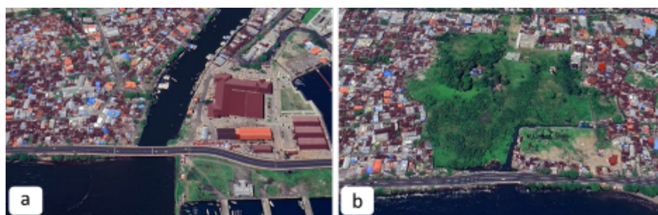
Gambar 7. Aerial sungai Tondano (a), sungai Maasing (b).
