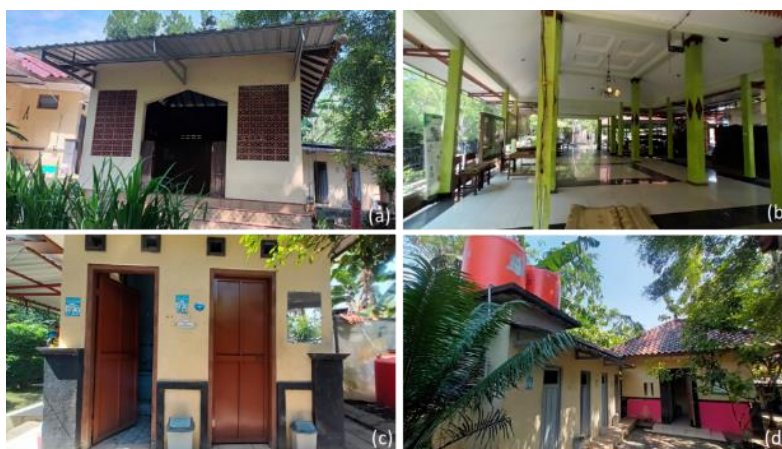
Gambar 7. Fasilitas penunjang yang tersedia di Kalisuci, antara lain: (a) Musala; (b) Ruang pertemuan (pendopo); (c) dan (d) Toilet dan kamar mandi.
