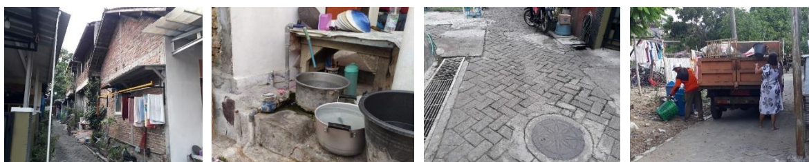
Gambar 2. Kondisi infrastruktur permukiman relokasi.
