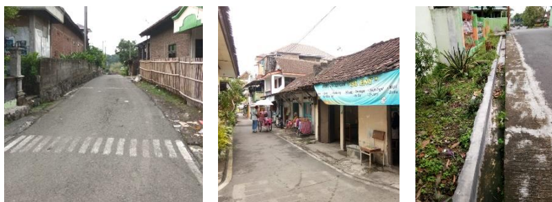
Gambar 8. Kondisi jaringan jalan dan drainase di kawasan sekitar relokasi.
