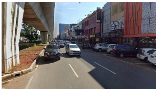
Gambar 3. Kondisi eksisting segmen 1
