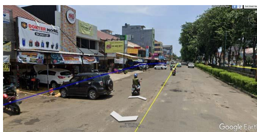
Gambar 11. Kondisi eksisting segmen 5.
