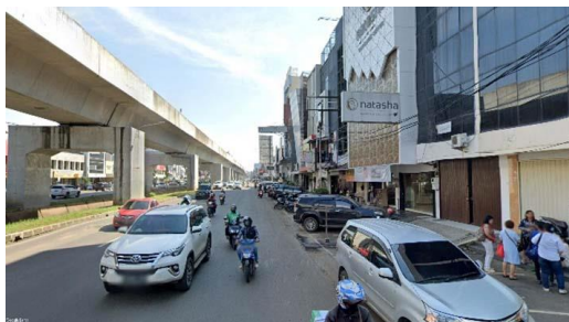
Gambar 5. Kondisi eksisting segmen 2.
