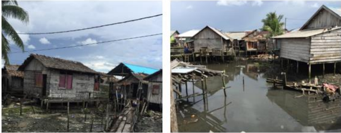
Gambar 2. Perumahan non permanen di Kabupaten Kepulauan Aru.
