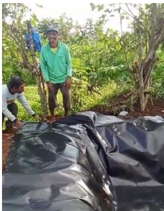
Gambar 6. Pemasangan geomembran
