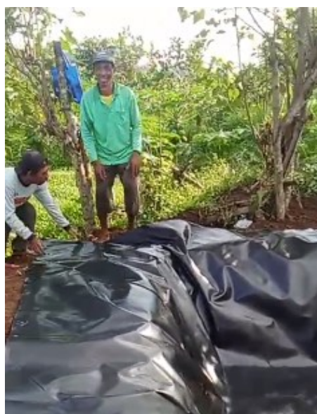
Gambar 6. Pemasangan geomembran
