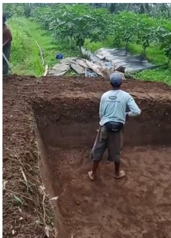
Gambar 4. Pembersihan lahan dan penggalian untuk pembuatan embung
