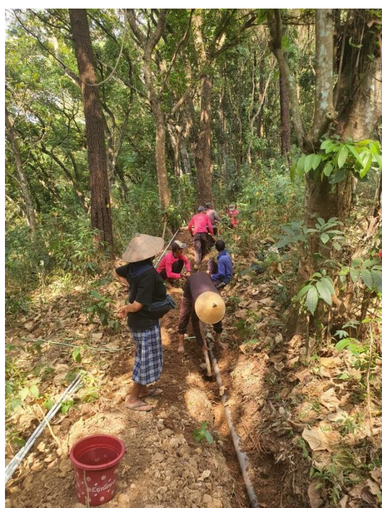
Gambar 2. Kegiatan penggalian dan pemasangan pipa irigasi
