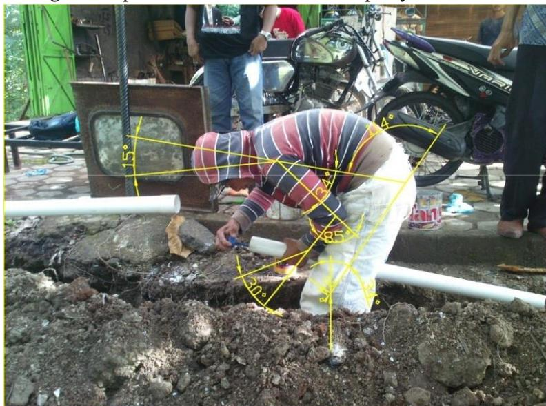
Gambar 4. Gerakan Memasang Pipa
