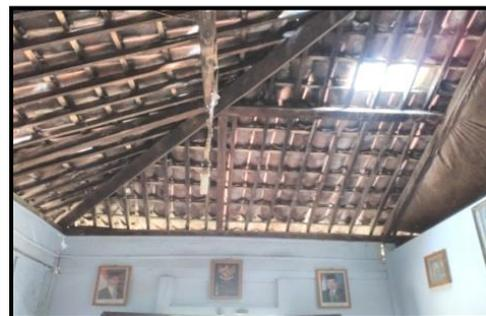
Gambar 1. Pemanfaatan *skylight* berupa genting transparan untuk memasukkan cahaya matahari melalui atap bangunan.
