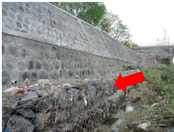
Gambar 1. Pemasangan Bronjong di Sungai Gajah Putih Surakarta
