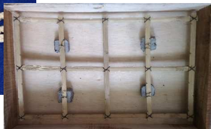
b. Bekisting dan Tulangan
