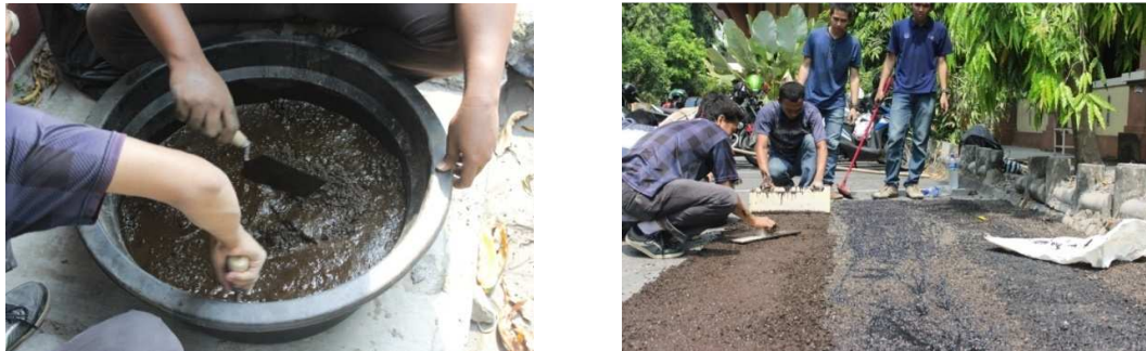
Gambar 1. Pekerjaan Penghamparan Slurry Seal
