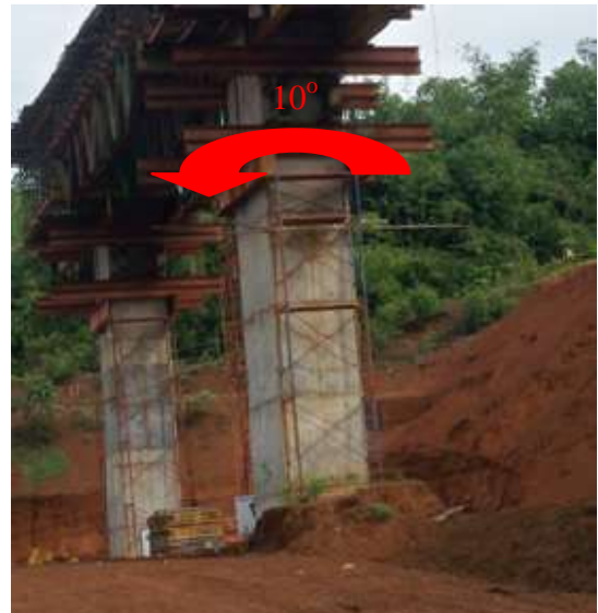
Gambar 1. (a) Peta Lokasi Penelitian, (b) Pilar yang mengalami failure
