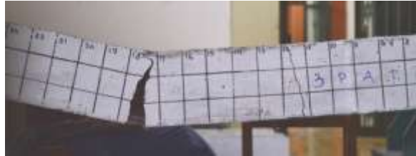
Gambar 8. Lokasi dan Pola Retak Balok PER 3
