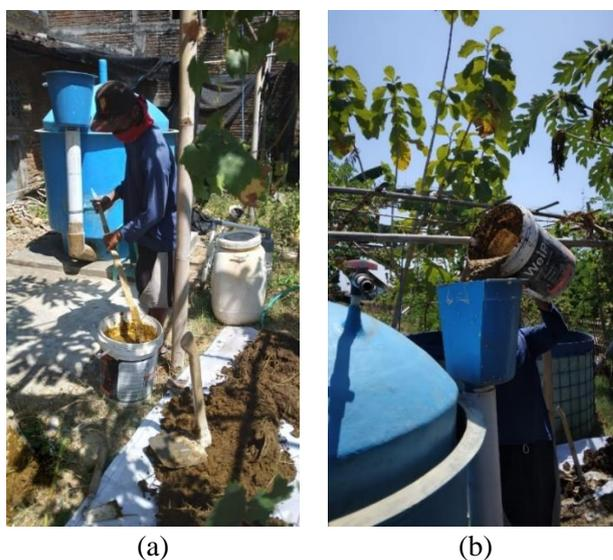
Gambar 5. Tahap awal pengisian reaktor biogas dengan kohe (a) pengadukan kohe dengan air dan (b) pengisian ke dalam reaktor melalui *inlet*
