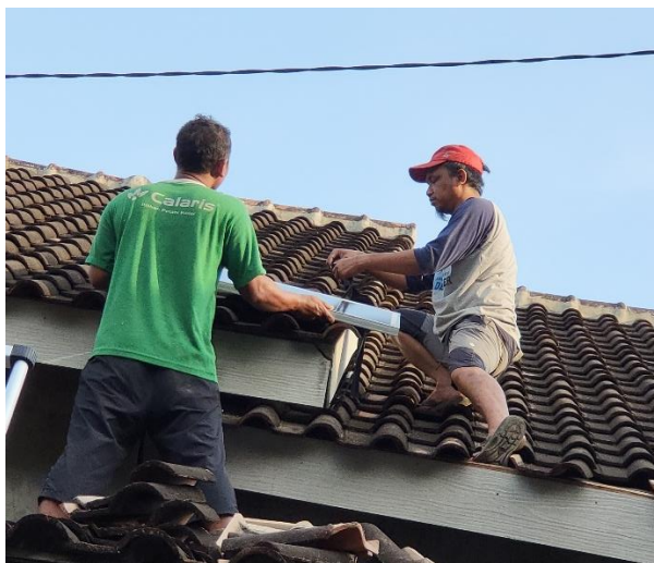
Gambar 4. Pemasangan panel surya di atap rumah
