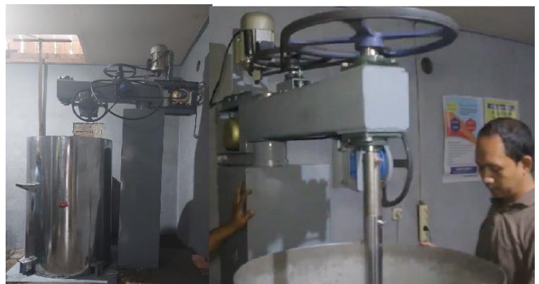
3b. Pengadukan menggunakan mesin pengaduk otomatis
