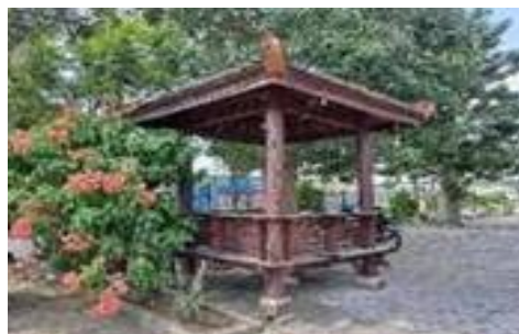
Gambar 2. Fasilitas Pendukung di Shelter Kembulsari
