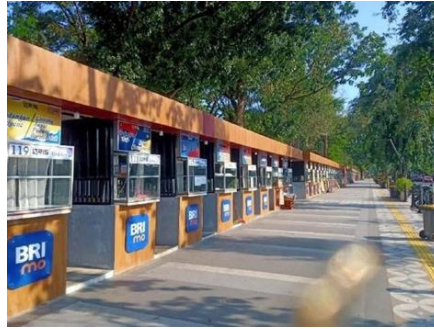
Gambar 3. Shelter Makanan di Kawasan Stadion Manahan
