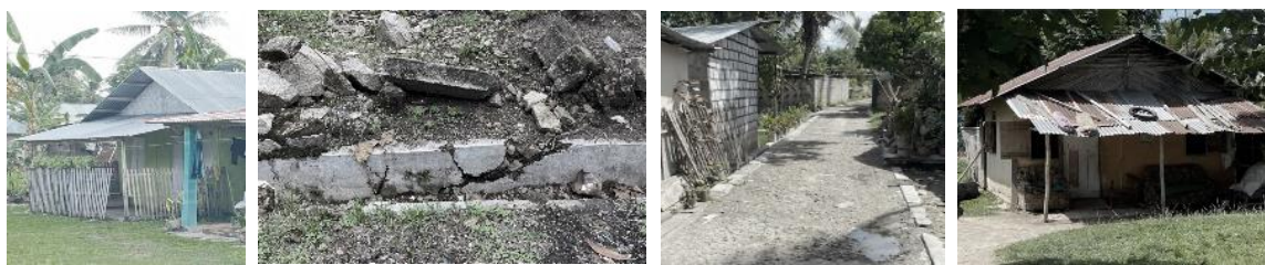
Gambar 4. Kondisi RTLH, Drainase, Jalan Lingkungan, dan RTLH
