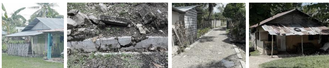
Gambar 4. Kondisi RTLH, Drainase, Jalan Lingkungan, dan RTLH
