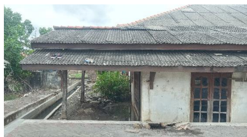
Gambar 7. Bangunan Rumah Tinggal Lebih Rendah dari Muka Jalan
