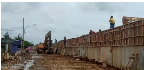
Gambar 9. Kondisi Kawasan Pesisir Sedang Dibangun Tanggul Laut
