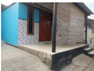
Gambar 6. Peninggian Bangunan Rumah Tinggal
