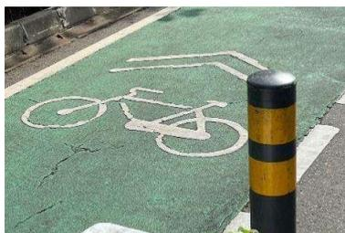
Gambar 16. Marka Jalur Sepeda
