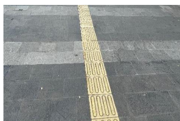
Gambar 5. Guiding Block pada Jalur Pedestrian
