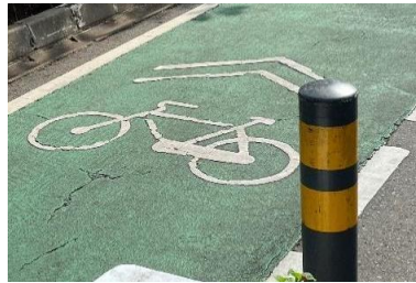
Gambar 16. Marka Jalur Sepeda
