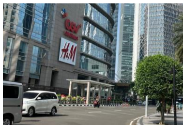
Gambar 12. Lantai Dasar Berbatasan Langsung dengan Jalur Pedestrian
