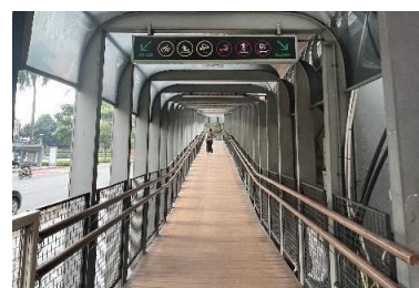
Gambar 10. Bidang Miring sebagai Akses di JPO
