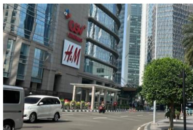
Gambar 12. Lantai Dasar Berbatasan Langsung dengan Jalur Pedestrian
