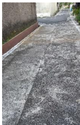
Gambar 9. Jalan Lokal di Kawasan Sondakan
