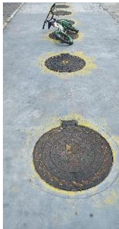
Gambar 6. IPAL Komunal di Kawasan Sondakan
