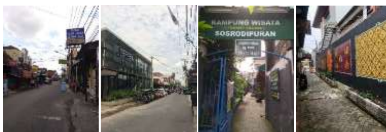
Gambar 9. Kondisi Perkerasan Jalan
