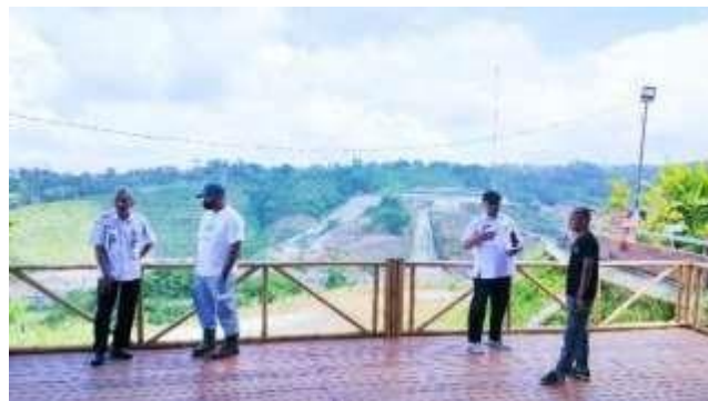
Gambar 1. Bangunan Pemantau Bendungan Jlantah
