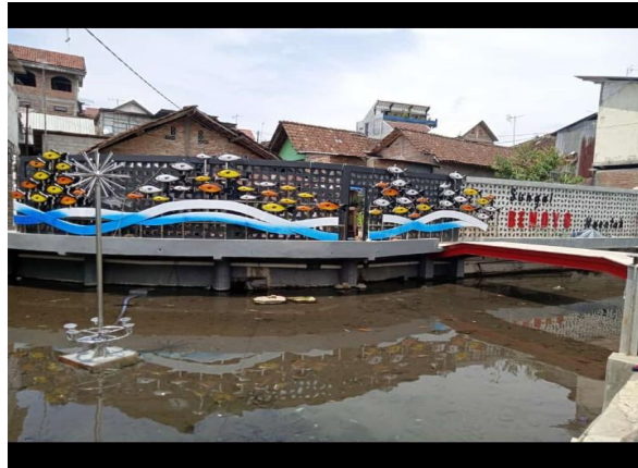
Gambar 4. Sumber Mata Air Kali Benoyo sesudah penataan
