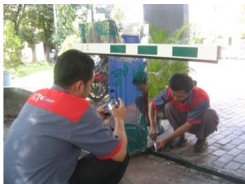
Gambar 10. Pemasangan dan Uji Coba Barrier Gate
