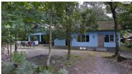
Gambar 2. Bangunan Sekitar Tapak
