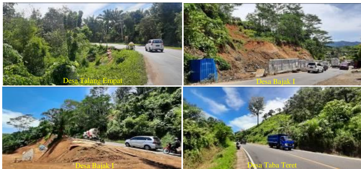
Gambar 5. Hasil observasi visual lokasi-lokasi rawan gerakan tanah di Kecamatan Taba Penanjung (jalur lintas Bengkulu Tengah-Kepahiang).
