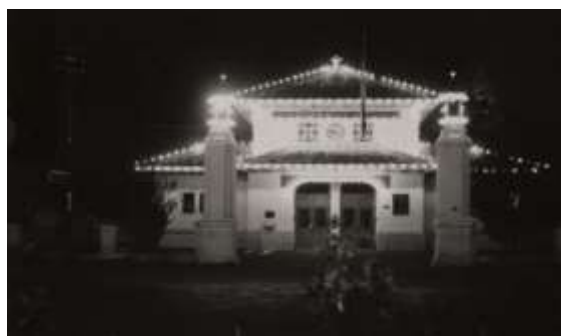
Figure 4. Kantoor van Nederlandsch Indische Escompto Maatschappij te Cheribon Source: https://digitalcollections.universiteitleiden.nl
