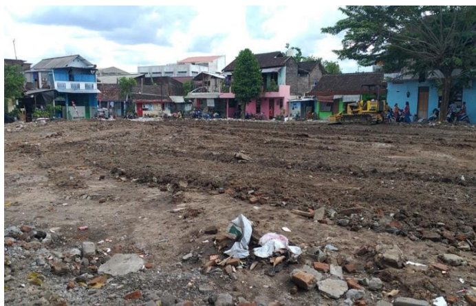
Gambar 1. Pembersihan dan Pembongkaran Bangunan di Kota Surakarta
