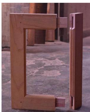
**Gambar 3.** Sambungan Purus dan Lubang pada Produk Jendela
