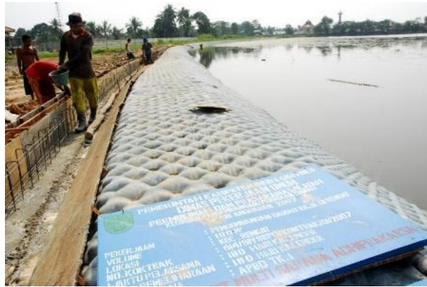
Gambar 5. Pemasangan geotextile Sumber: direktoripariwisata.id, 2007
