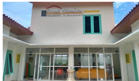
Gambar 6. Bangunan Penginapan Desa Sendang
