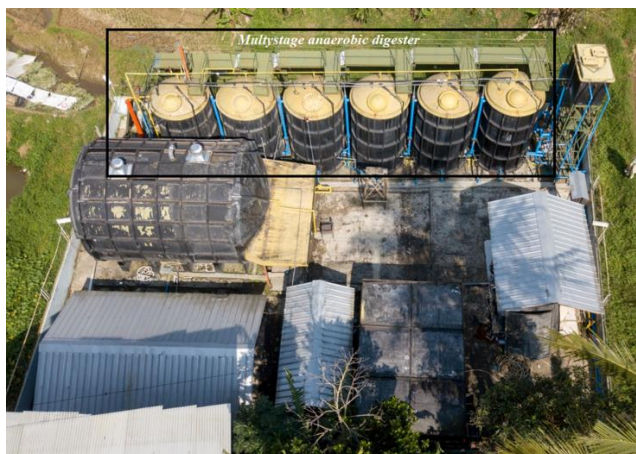
Gambar 4. Reaktor multistage anaerobik digester limbah tahu di Dusun Giriharja, Kabupaten Sumedang, Jawa Barat.
