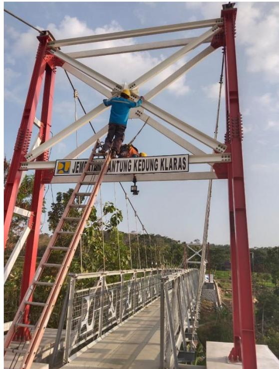
Gambar 4 Pemasangan Lampu Penenrangan Jembatan
