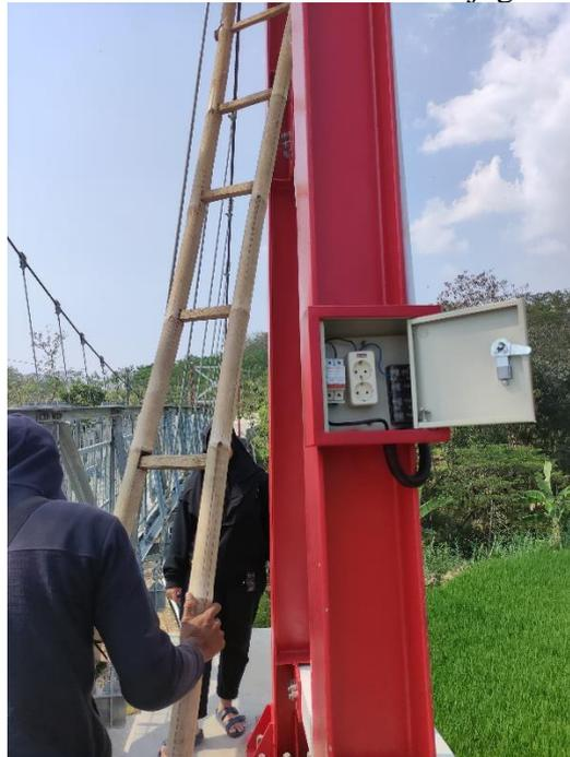
Gambar 1 Pemasangan Instalasi Listrik Jembatan
