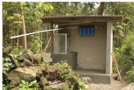
Gambar 3. Hasil Tempat Instalasi Air Sumber: Dokumentasi Pengabdian, 2021
