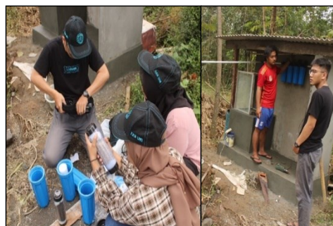
Gambar 2. Proses Perakitan dan Proses Pemasangan Filter Air Sumber: Dokumentasi Pengabdian, 2021
