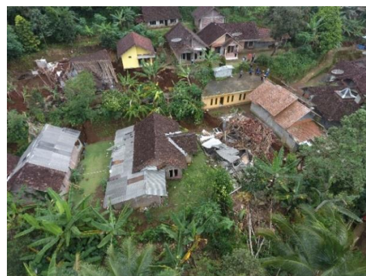
Gambar 1. Kerusakan infrastruktur akibat longsor bulan Januari 2021
