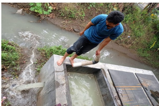
Gambar 1.1 Pengontrolan Filter Pengolahan Limbah Cair Tahu Sumber : Dokumentasi Kegiatan (2021)
