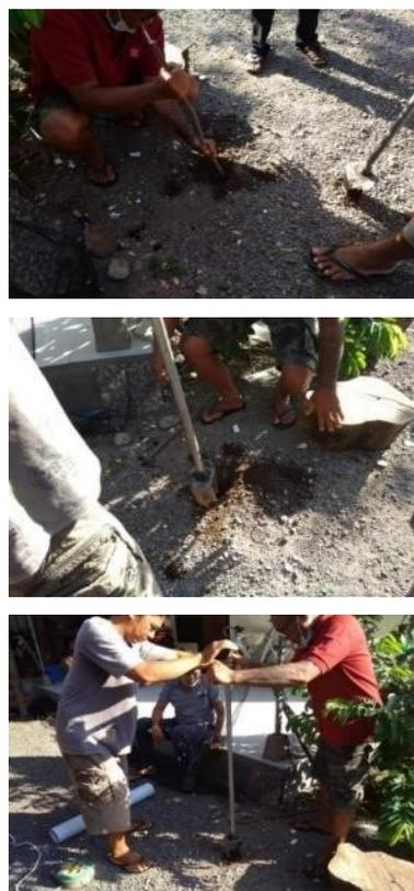
Gambar 6. Pembuatan lubang pada tanah dengan bor tangan.
