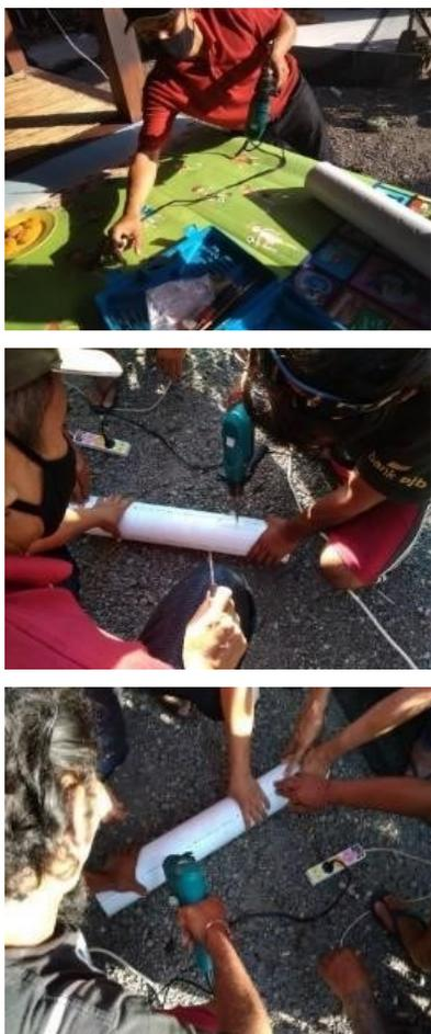
Gambar 5. Kegiatan pengeboran lubang pori pada pipa pvc
