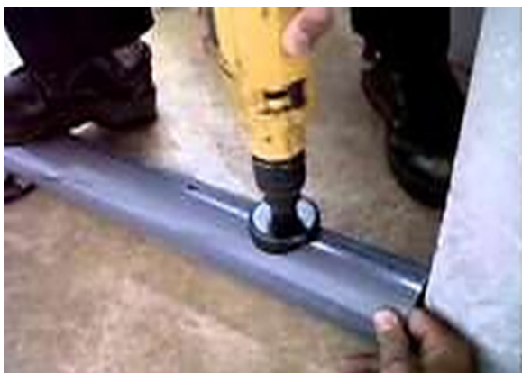
Gambar 2. Pelubangan pipa paralon
